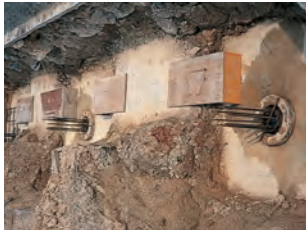
土工事 2 (掘削工事)
