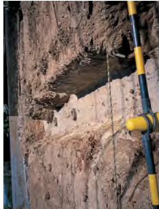
土工事 1 (掘削工事)
