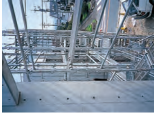
型枠脱枠工事 1
