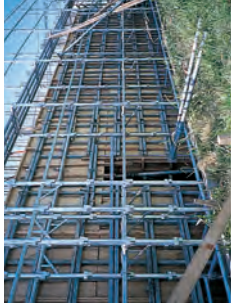
躯体工事 3 (型枠工事)
