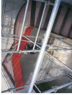
鉄骨工事 3 (階段工事)
