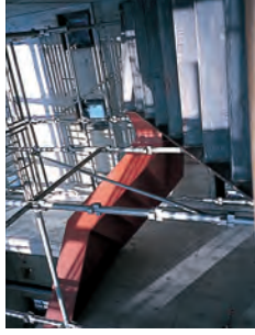
鉄骨工事 2 (階段工事)
