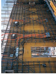
躯体工事 1 (鉄筋工事)
