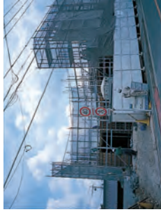
足場工事 6 (シート貼)
